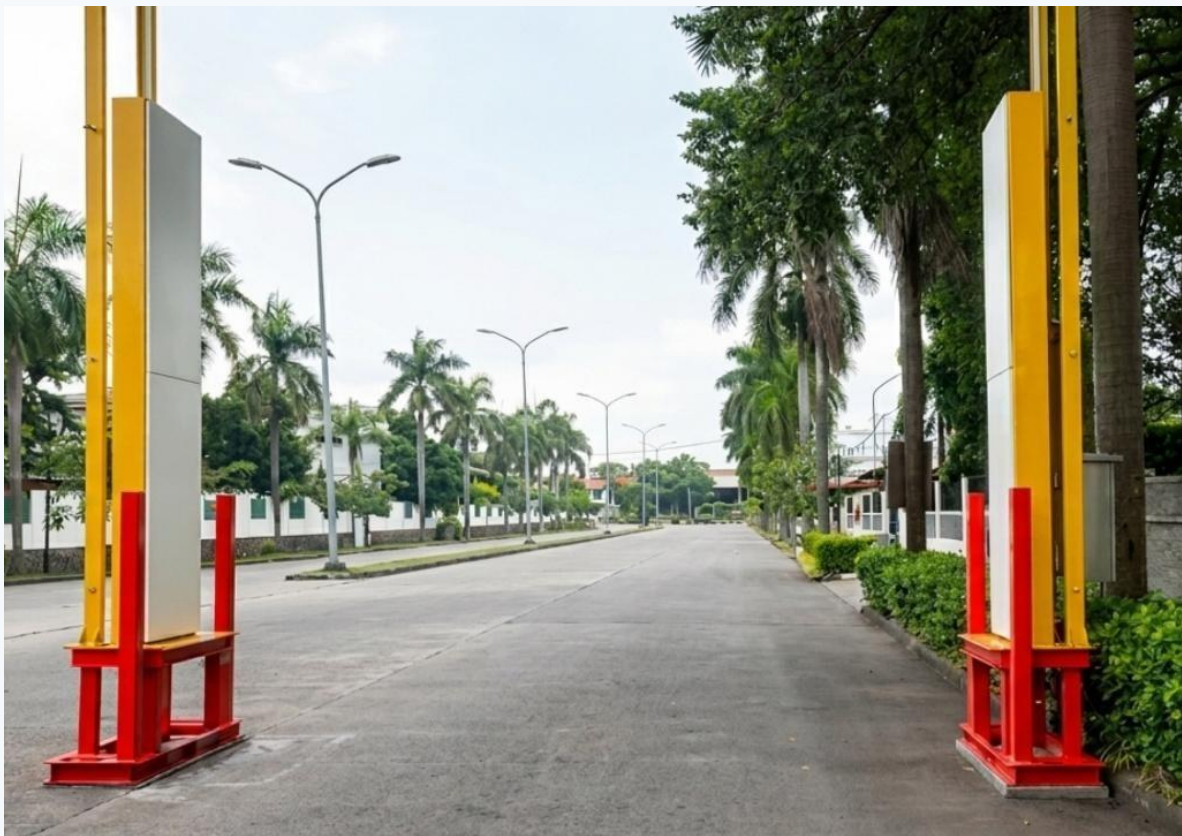
Desain dimensi pilar gantry permanen luar ruangan yang kokoh untuk menampung modul sensor pemantau radiasi.
