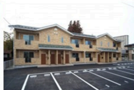
盛岡市 集合住宅新築工事
