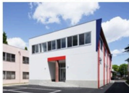
仙台市 事務所ビル新築工事
