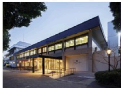
柏市 キャンパスプラザ改修工事
