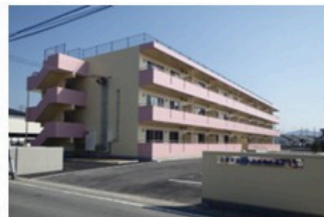
石巻市 災害公営住宅新築工事
